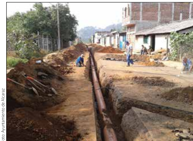
Figura 2. Construcción de drenaje.
